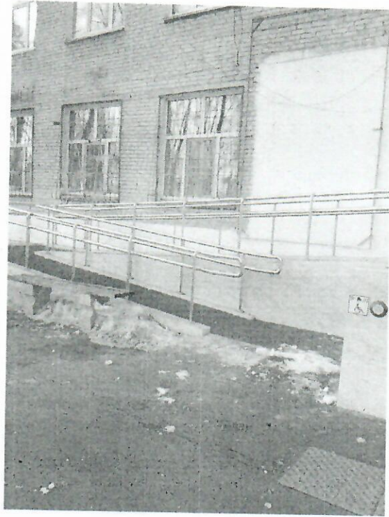
Фото №5. Пандус возле центрального входа в здание КГБОУ ШИ 2 с двойными поручнями и кнопкой вызова.
