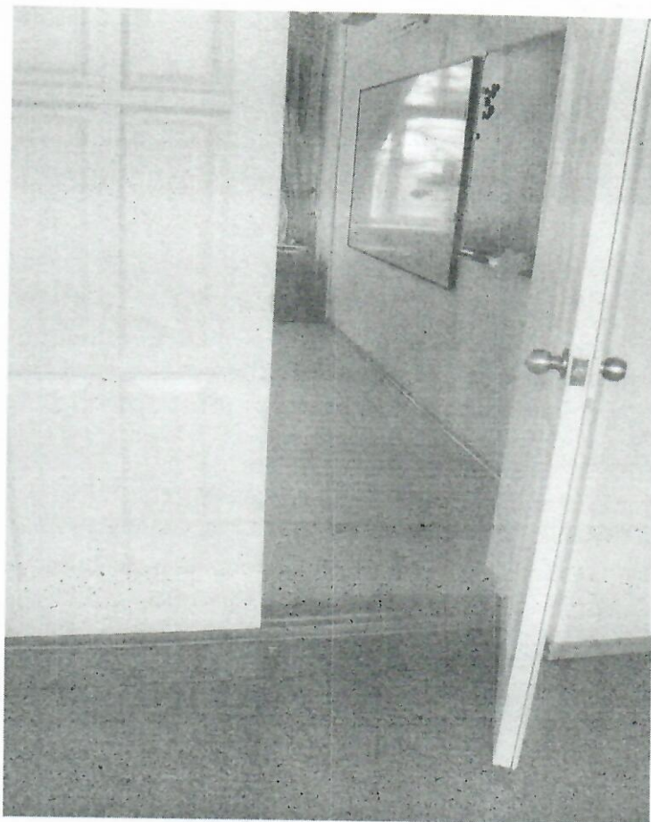
Фото №33. Вход в учебный класс, расположенный на 2 этаже здания КГБОУ ШИ 2.
