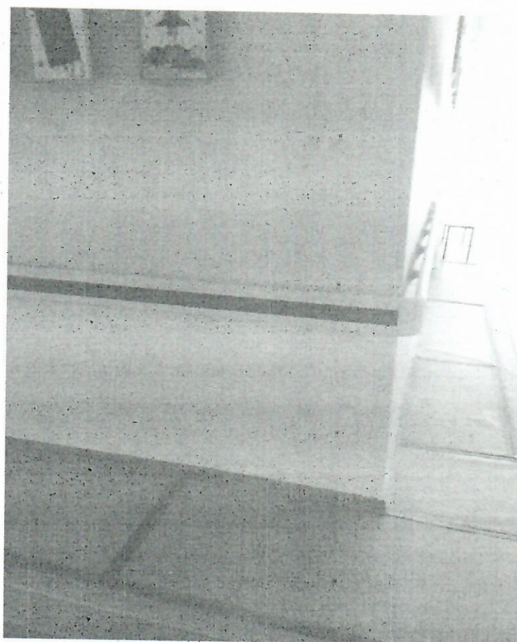
Фото №20. Поручни на стенах в здании КГБОУ ШИ 2.
