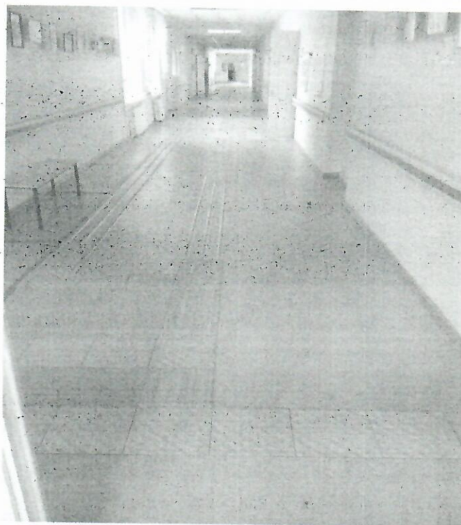
Фото №16. Общий вид коридора внутри здания КГБОУ ШИ 2 с выделенными путями движения.
