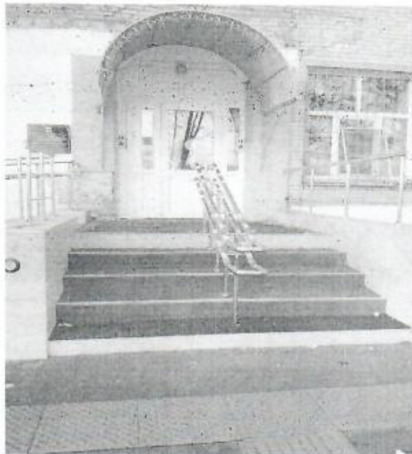
Фото №4. Вид внешней лестницы в КГБОУ ШИ 2 с выделенными желтым цветом нижней и верхней ступеней, двойными поручнями с тактильными наклейками желтого цвета.
