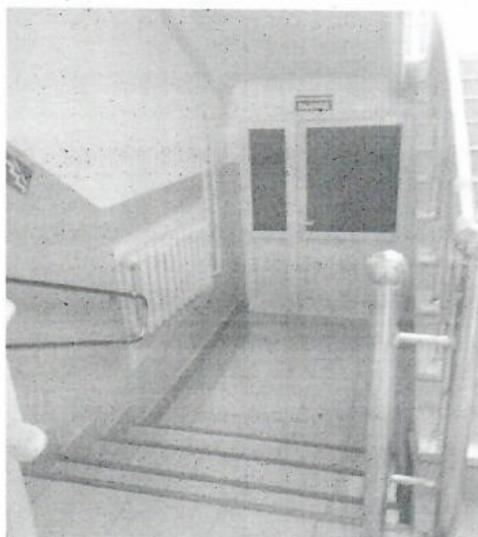
Фото №10. Запасной выход из здания КГБОУ ШИ 2 с западной стороны (вид внутри здания), оборудованный двойными поручнями.
